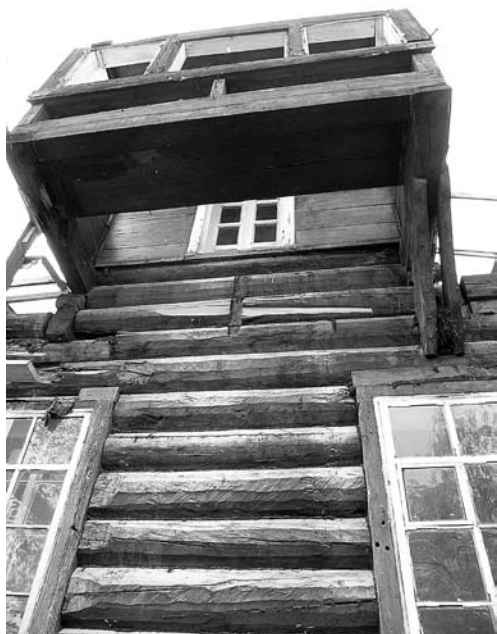
Конструкция мезонина на южном (дворовом) фасаде. 2007. Фото И.П. Пинайкина
