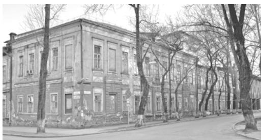
Ил. 8. Дом по ул. 5-й Армии, 65, бывший военный госпиталь. Фото И. Бержинского. 2011 г.
